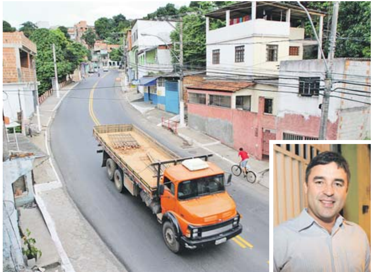
RODOVIA SERAFIM DERENZI: para moradores como Jackson Silote (destaque), obra deve atrair investimentos
