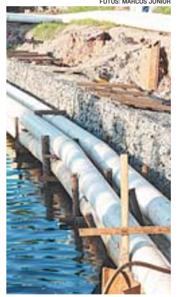
CANAL DO CONGO: obras contemplam construção de contenção nas margens do canal principal, instalação de nova rede de manilhas e galerias num percurso de 14 quilômetros. Essa obra vai beneficiar diretamente 13 bairros de Vila Velha e 50 mil habitantes
