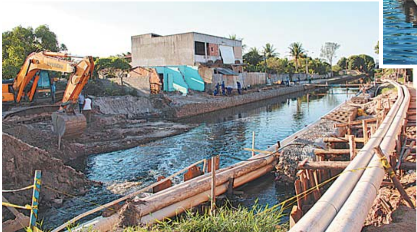
CANAL DO CONGO: obras contemplam construção de contenção nas margens do canal principal, instalação de nova rede de manilhas e galerias num percurso de 14 quilômetros. Essa obra vai beneficiar diretamente 13 bairros de Vila Velha e 50 mil habitantes
