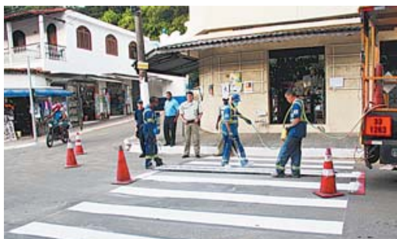
PINTURA DE FAIXAS de pedestre nas ruas da Prainha e do Centro
