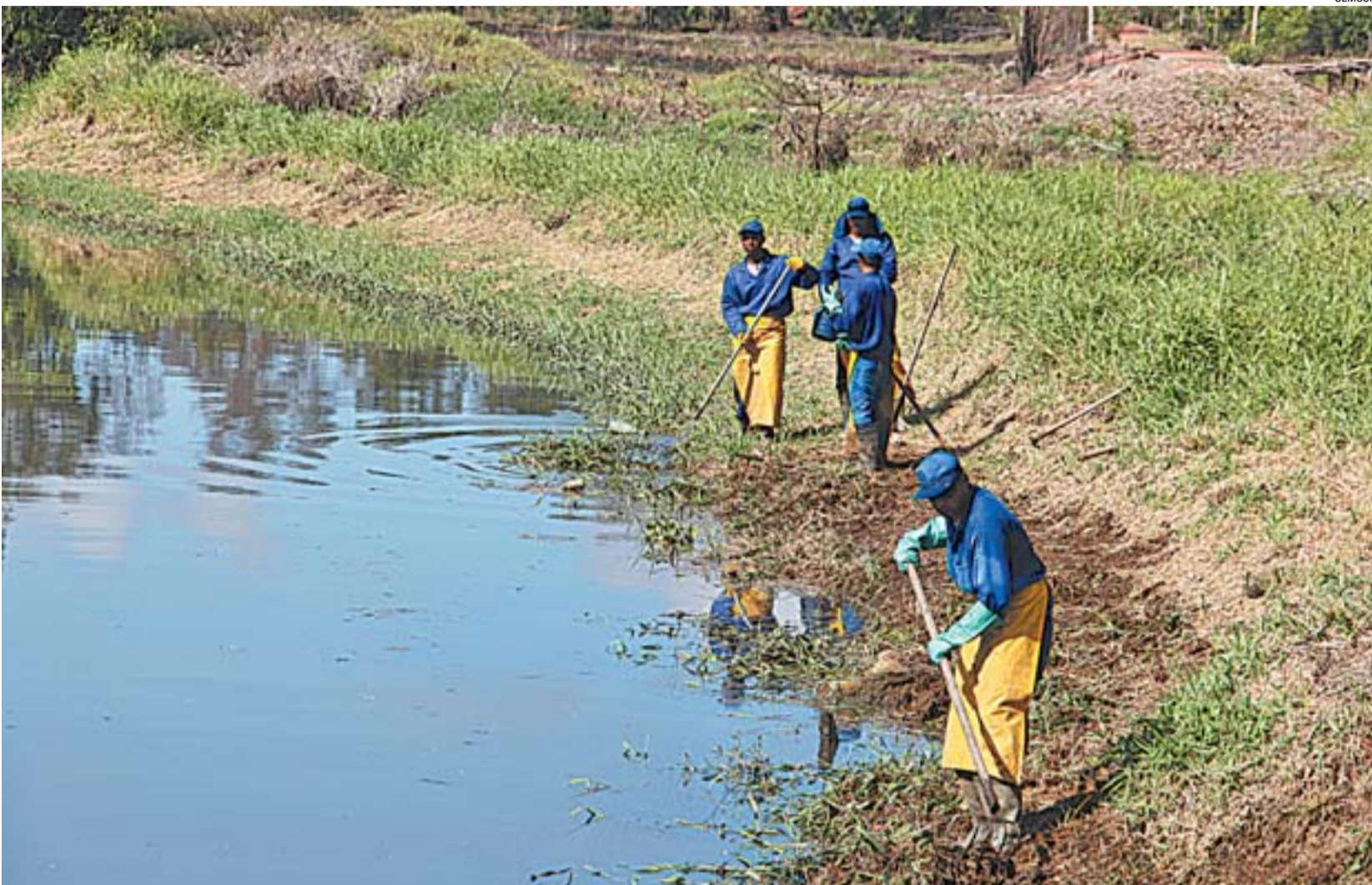
A CADA 45 DIAS acontece um ciclo de limpeza nos canais que cortam o município. São 50 toneladas por mês de material, como mato, móveis e entulhos
