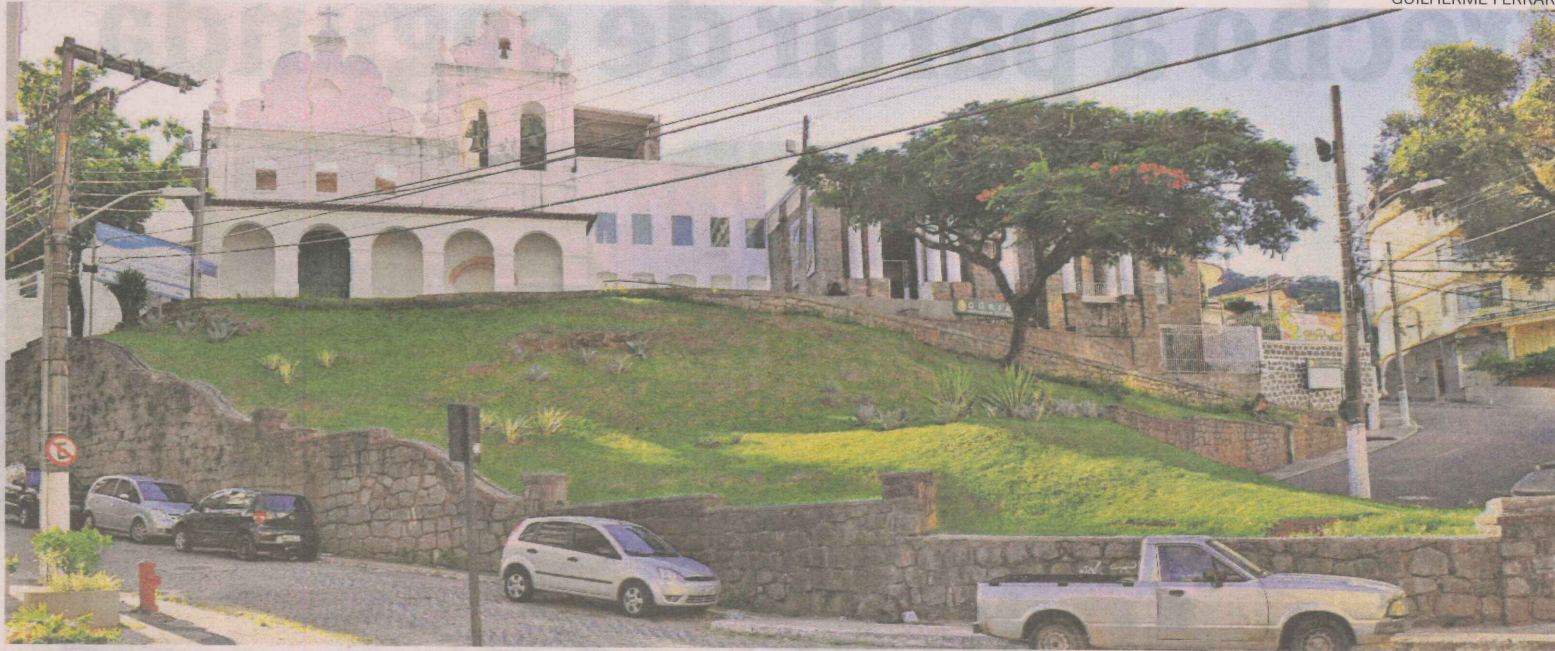
Com a mudança na iluminação, os fios que ficam em frente à fachada do Convento de São Francisco passarão a ser subterrâneos
