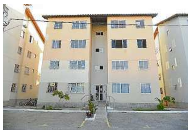
Edifício Robalo, interditado pela Defesa Civil
