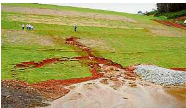
Um das primeiras ocorrências foi identificada em 2009, quando ocorreram infiltrações e a água começou a vazar fora das paredes dos diques. Um sinal, segundo o perito, de que havia falha da construção dos drenos de fundo da barragem e que não poderiam mais ser usados. Eles foram substituídos por um tapete drenante, que só retirava a água a partir da marca 826, não retirando a água que permanecia no fundo
