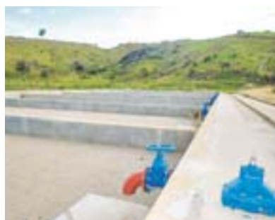
OBRA da ETE de Barbados: ajustes
