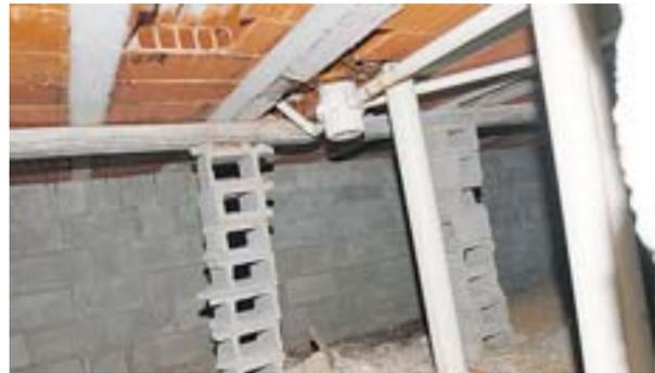
**SEGURANDO** as vigas que sustentam o prédio foram colocadas colunas improvisadas com blocos de cimento sobrepostos, para sustentar a fundação do prédio na base subterrânea.
