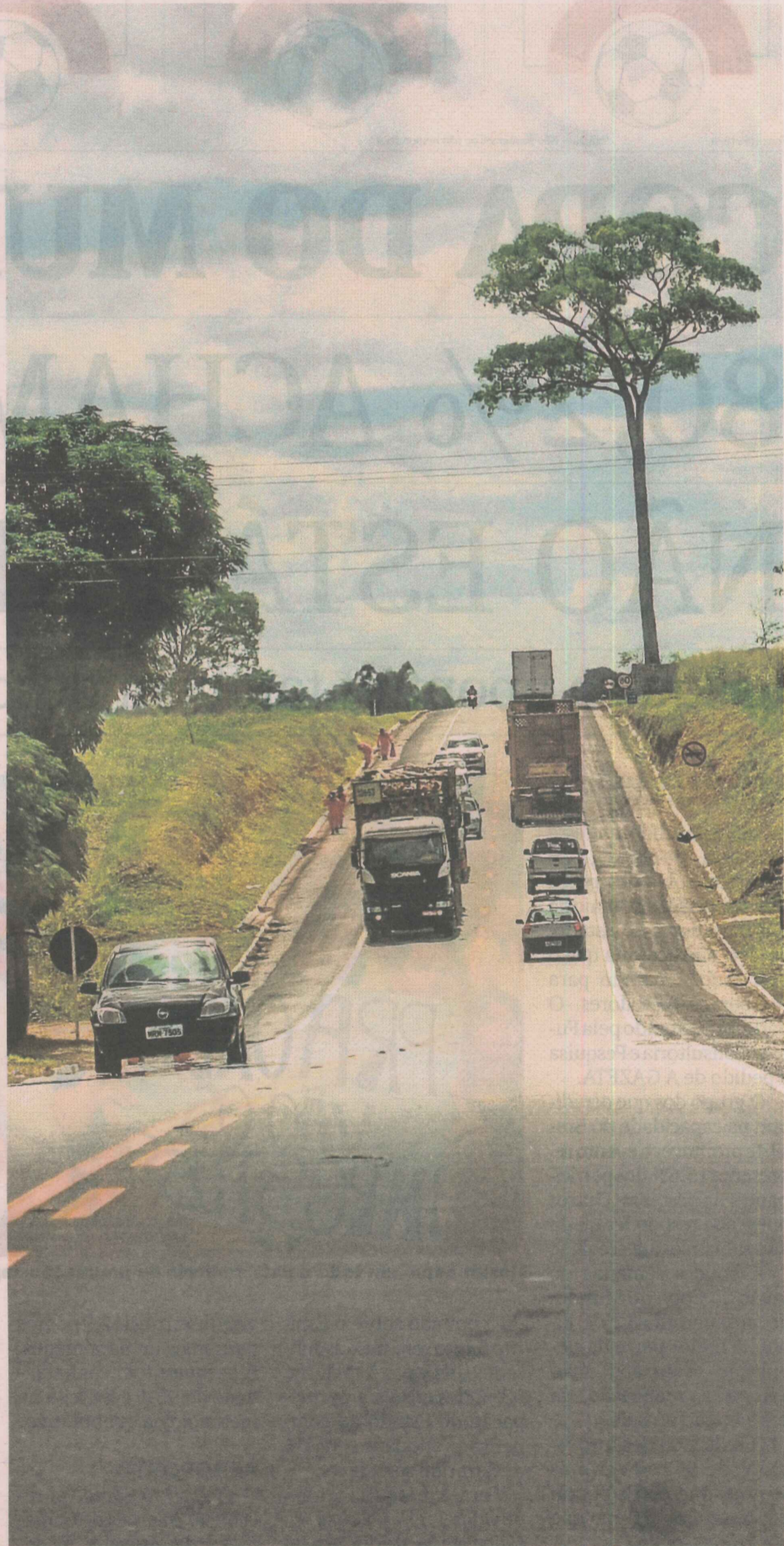
Sinalização da via e nivelamento do acostamento com a pista: medidas aplicadas
