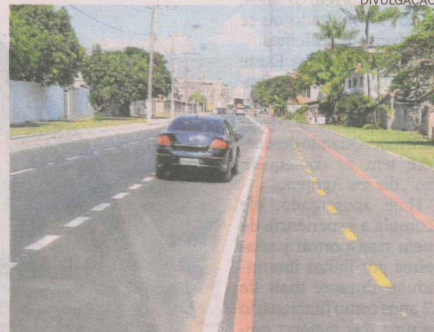
Via pavimentada no bairro Divino Espírito Santo
