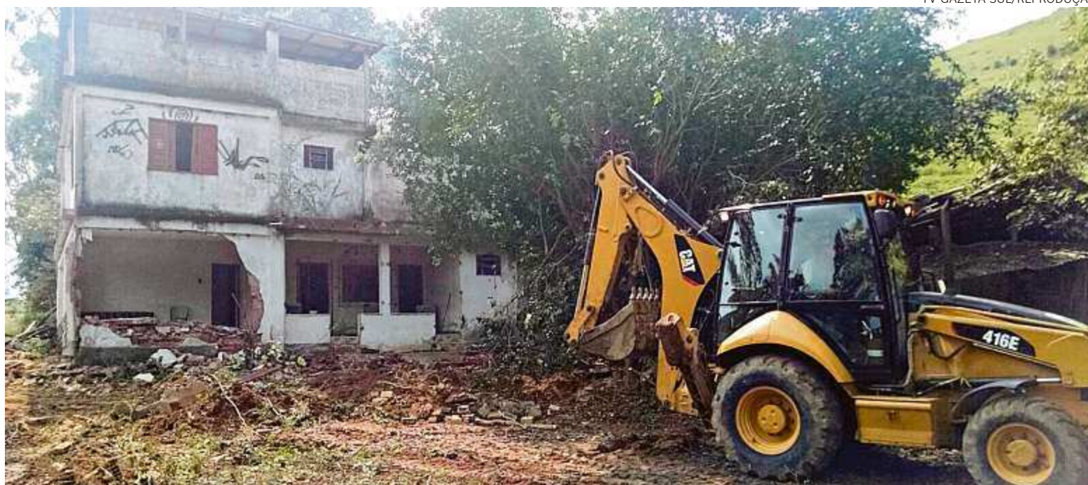
O primeiro imóvel demolido fica em propriedade não habitada às margens da BR 101, no km 363, em Anchieta, Sul do Estado
