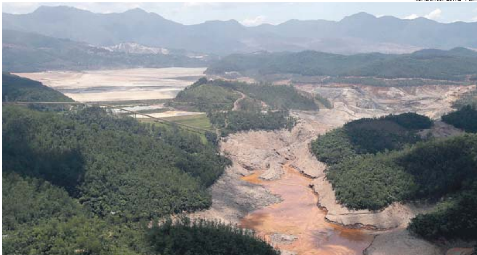
BARRAGEM DA MINERADORA SAMARCO em Mariana (MG), que rompeu em novembro do ano passado, causando o maior desastre ambiental do País
