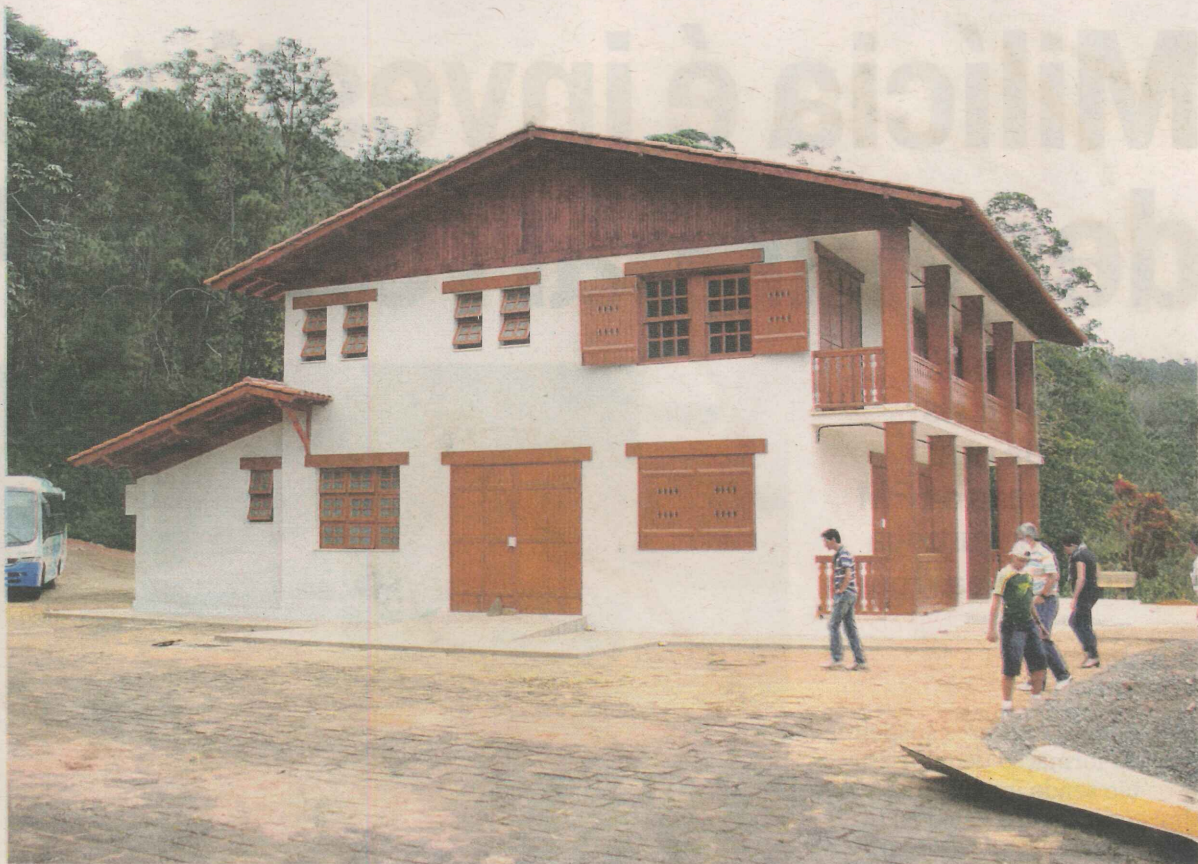
CASA DE INVERNO do governo do Estado será doada para empreendimento, que terá cinemas e piscinas térmicas
