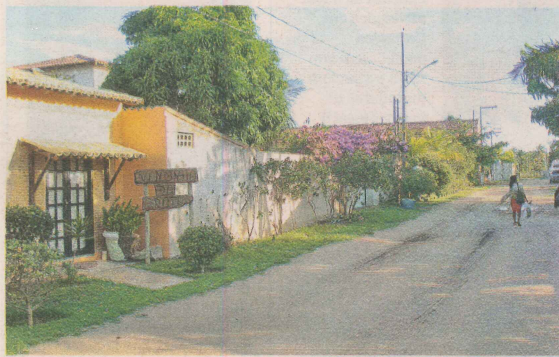
POUSADA em Barra Nova que corre risco de ser demolida pelo Estado
