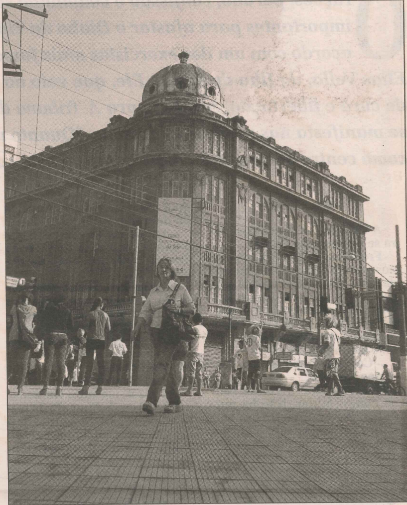
Fachada do Teatro Glória, que será um centro cultural
