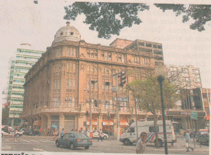
PREVISÃO. Reformas no prédio começam em janeiro. FOTO: GABRIEL LORDÉLLO
