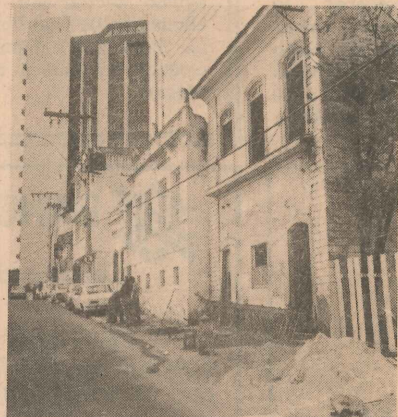
Casarões: correndo riscos
