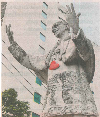
PAPA PIO XII , que fica na praça de mesmo nome. Além de pequenas rachaduras, está com o dedão da mão esquerda quebrado.
