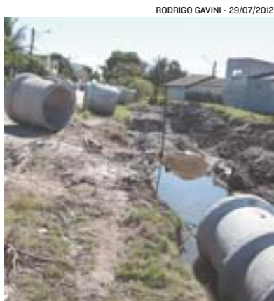
REDE DE ESGOTO: ampliação
