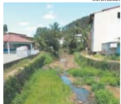
RIO BANANAL: emergência
