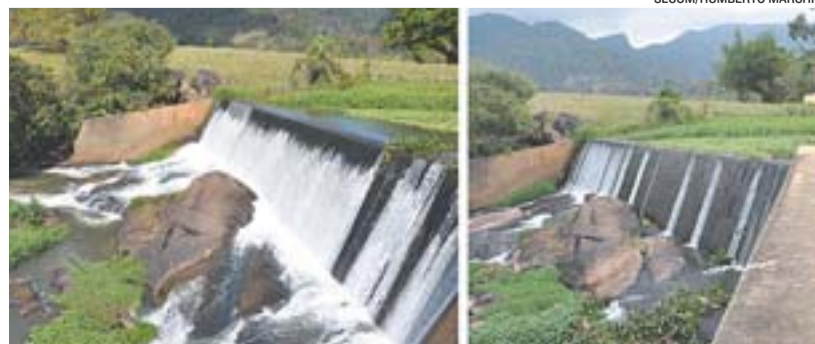
BARRAGEM de Santa Maria, em Aracruz, antes e depois da seca
