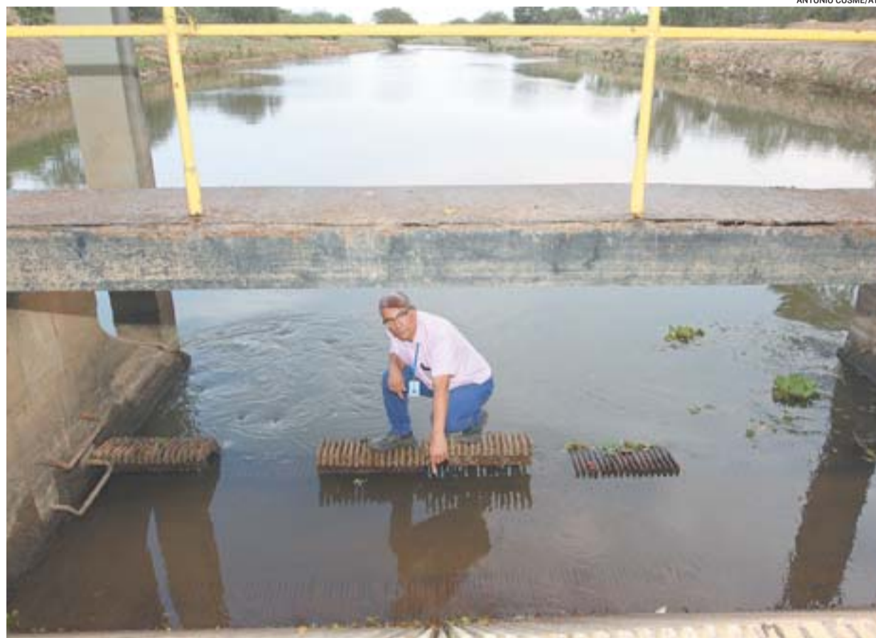
TÉCNICO mostra o nível baixo do Rio Jucu na região onde água é captada para abastecimento na Grande Vitória
