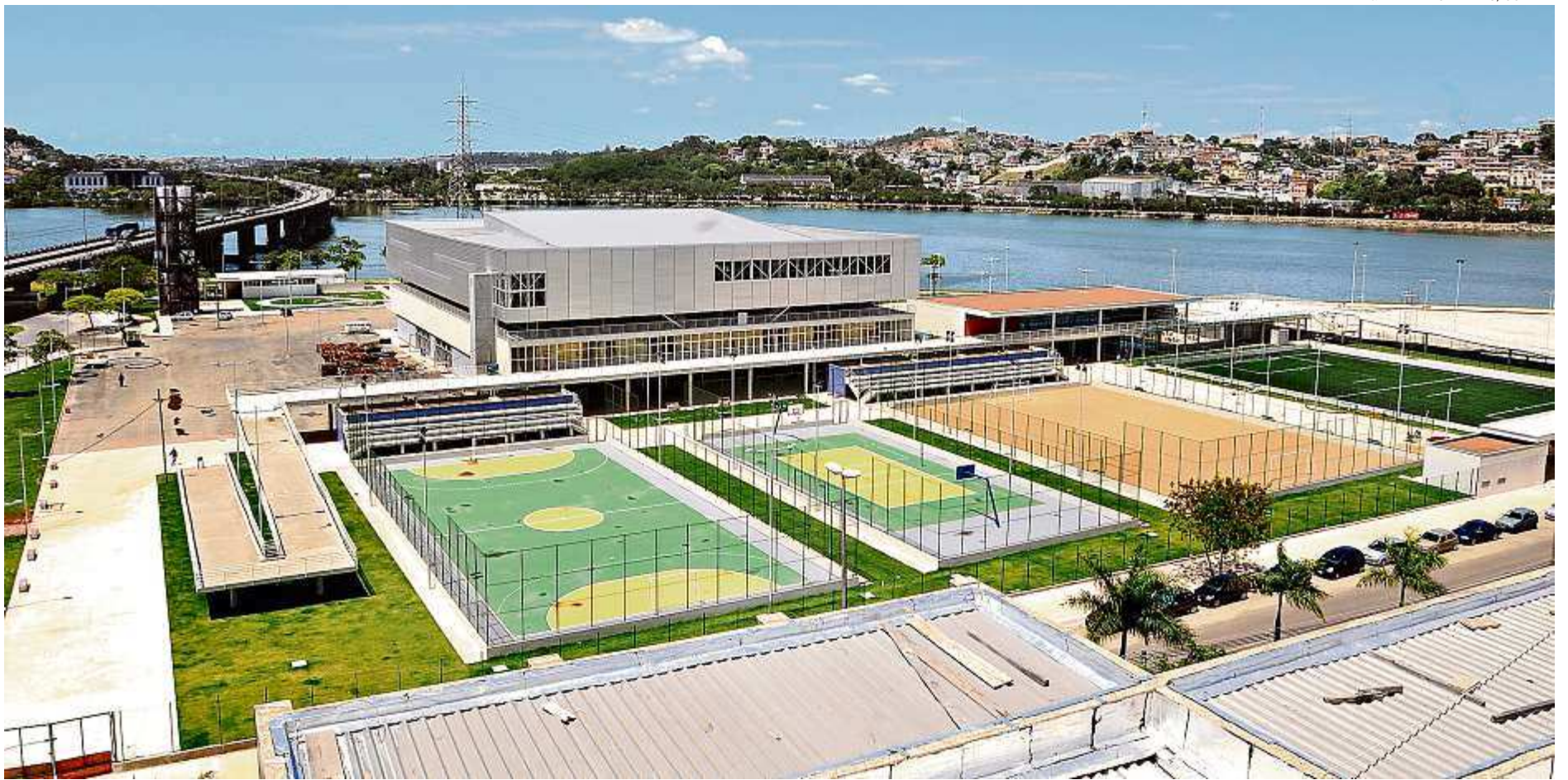
Anunciadas em 2006 com valor estimado em R$ 15 milhões, as obras do Tancredão só foram concluídas em dezembro de 2011, com custo total de R$ 41,6 milhões
