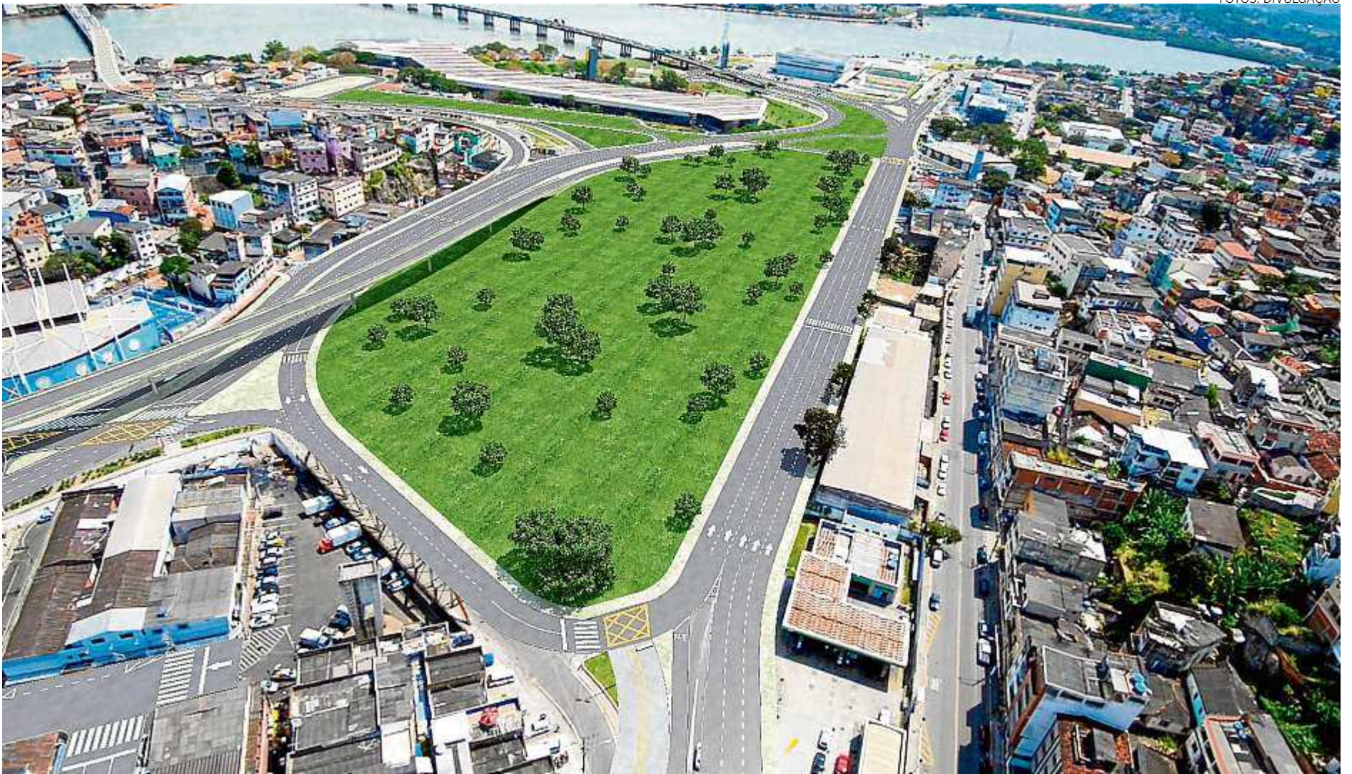
FAZEM PARTE DO PROJETO: drenagem, sinalização vertical e horizontal, paisagismo e adequações viárias. Objetivo é melhorar a circulação na região da Ilha do Príncipe
