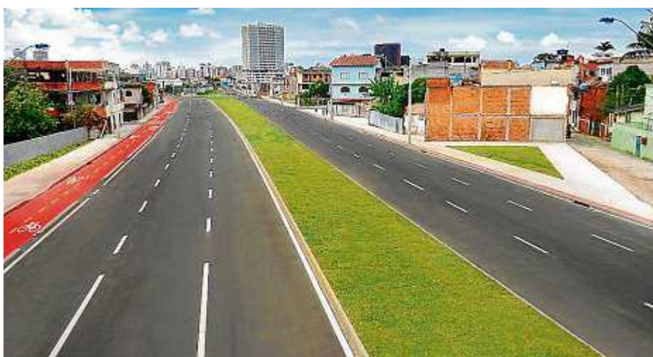
AS OBRAS do trecho 2 do Canal Bigossi fazem parte do Programa de Mobilidade Metropolitana
