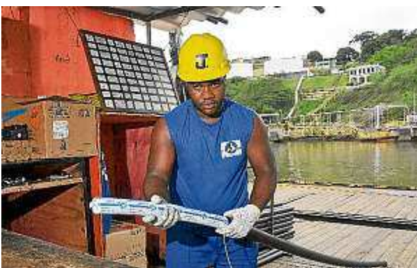
Operário prepara cartucho para detonar pedras
