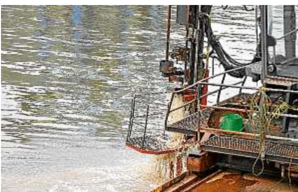
Perfuratriz instalada em balsa na Baía de Vitória
