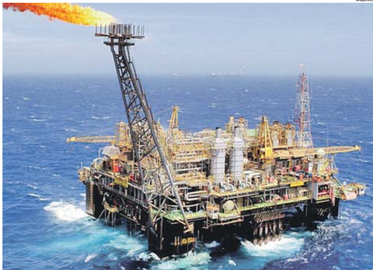
PLATAFORMA DE PETRÓLEO: interligação de poços na semana passada contribuiu para Petrobras atingir a marca
