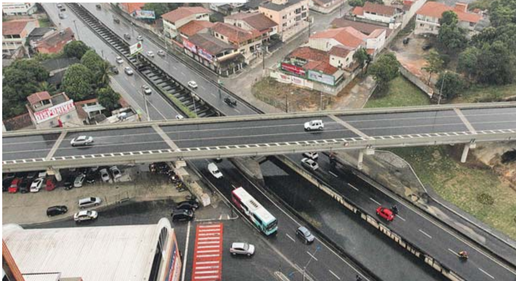
ALÇA DA TERCEIRA PONTE COM AVENIDA CARIOCA faz parte do pacote de obras realizadas para melhoria da infraestrutura viária na Grande Vitória
