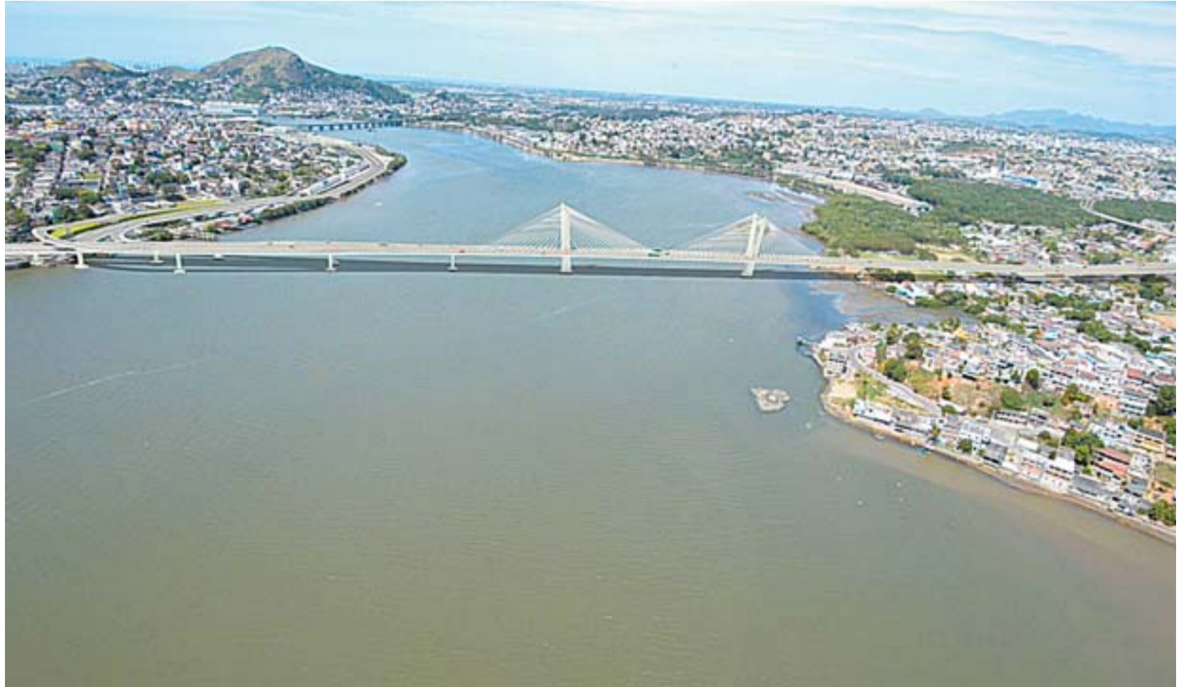
NOVA LIGAÇÃO ENTRE CARIACICA E VITÓRIA, a Quarta Ponte terá capacidade operacional para 3.600 veículos, além de corredor de ônibus e ciclovia
