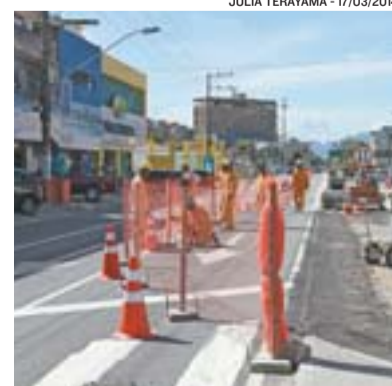
TRABALHADORES atuam em obra
