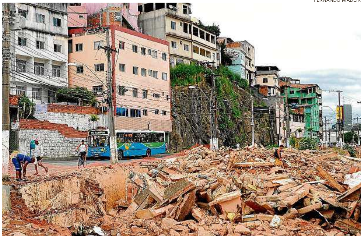
Cinco construções já foram derrubadas e darão lugar a viaduto que vai dar acesso ao Porto de Vitória
