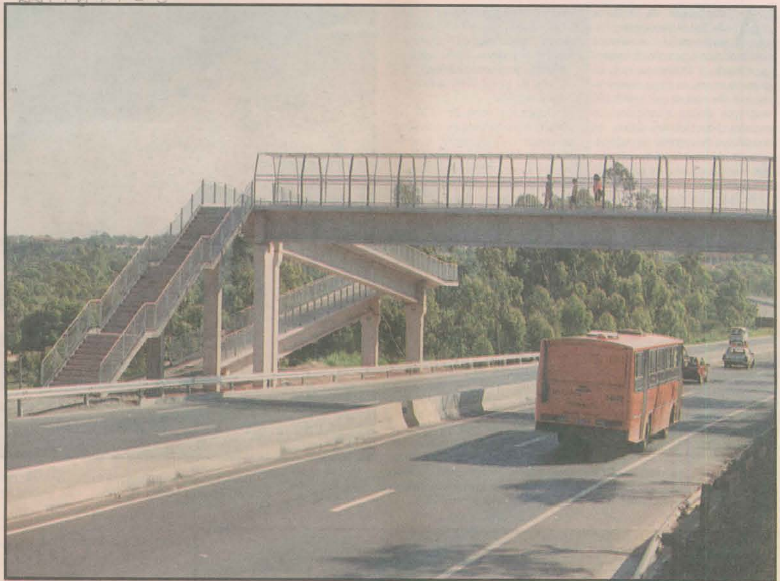
Ao todo, serão seis passarelas ao longo da Rodovia do Sol. Somente no trecho entre a Reserva de Jacarenema e a passagem de Terra Vermelha são quatro passarelas e mais um ponto de travessia de pedestre por baixo da rodovia
