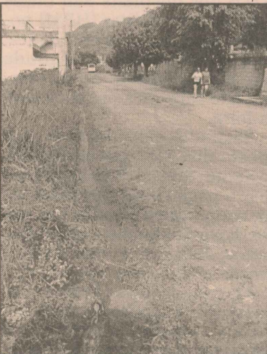
Esgoto aberto na rua
