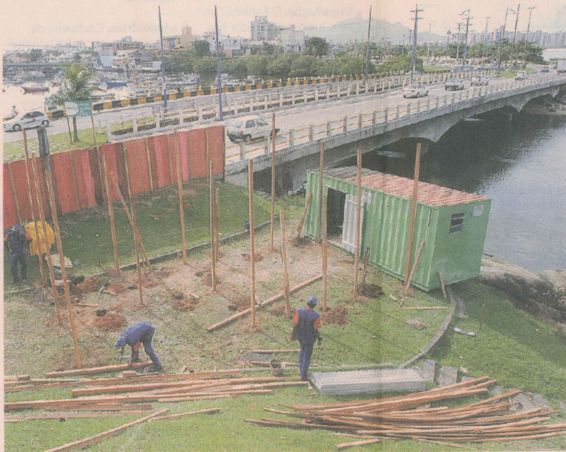
CONFUSO. Com o início das intervenções, o trânsito próximo à Ponte de Camburi está mais complicado. FOTO: CARLOS ALBERTO DA SILVA/ARQUIVO
