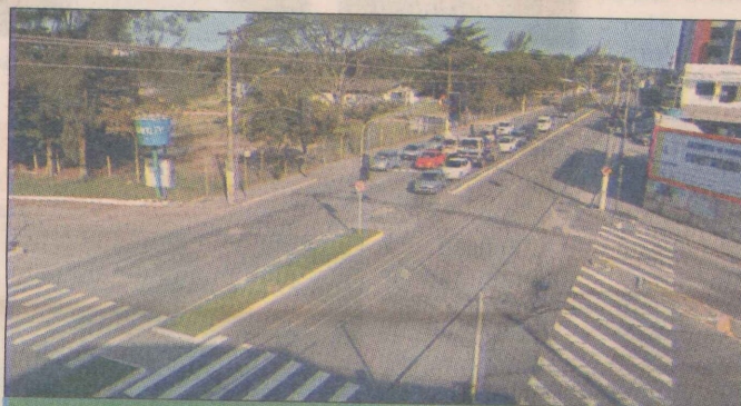
REFORMAS E CONSTRUÇÕES DE AVENIDAS
