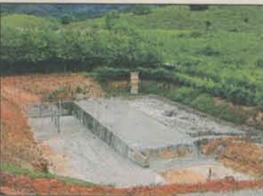
Tanque de concreto
