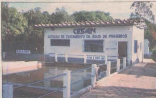
Estação de tratamento em Pinheiros
