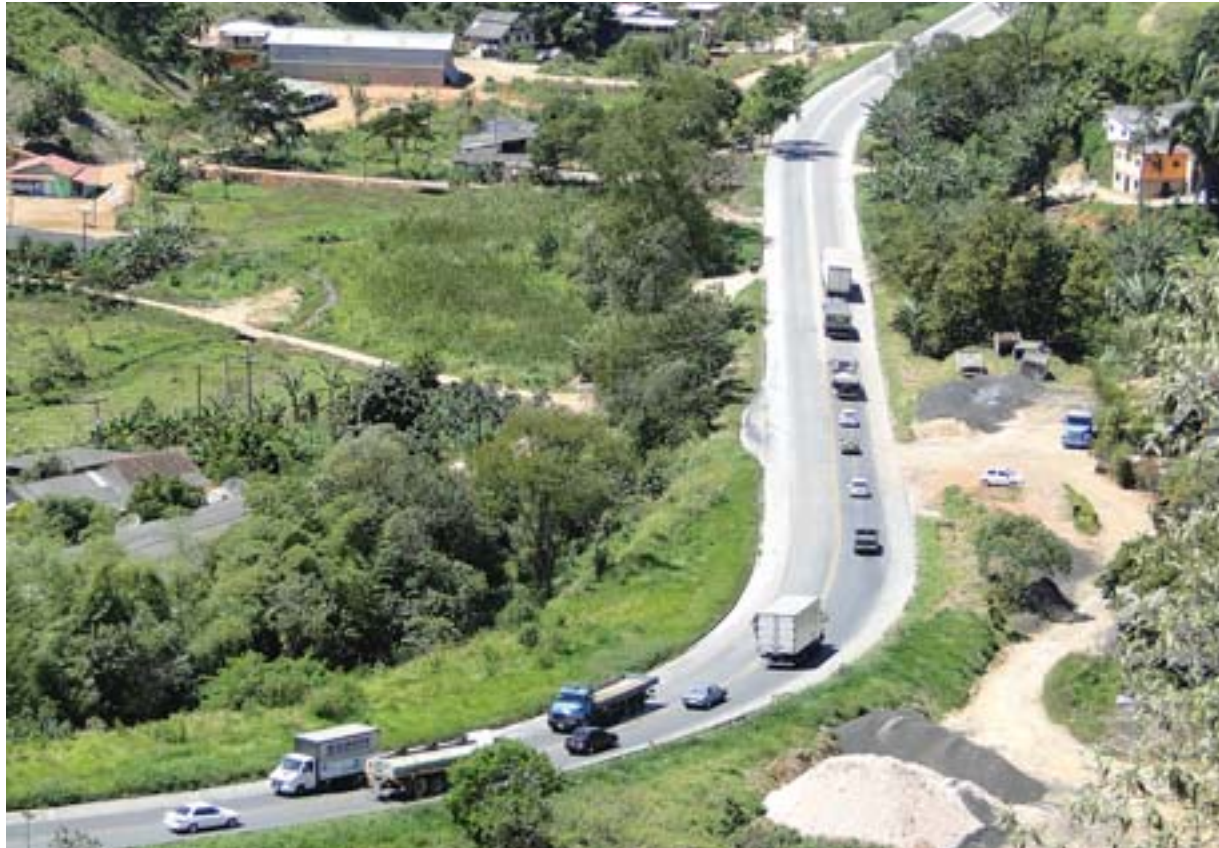
BR-262: contratação de projeto básico e executivo de engenharia e obras de duplicação não tem data para sair
