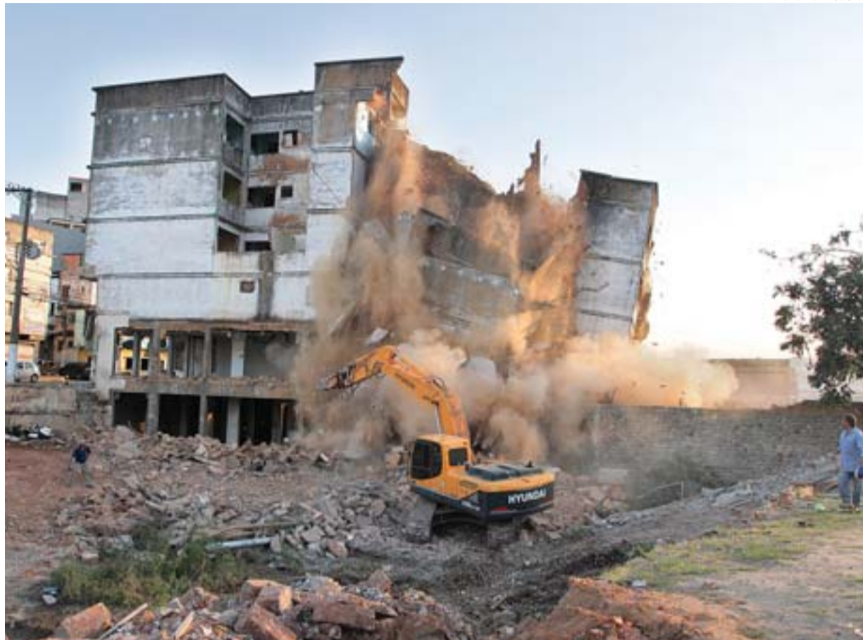
PRÉDIO NA ILHA DO PRÍNCIPE foi demolido para obras do Portal Sul, que também vão mudar o trânsito na região
