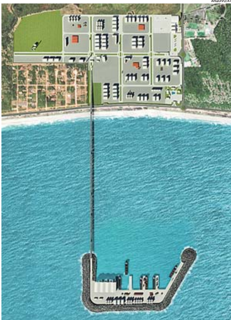
PERSPECTIVA do porto Itaoca Offshore: conclusão das obras em 2016
