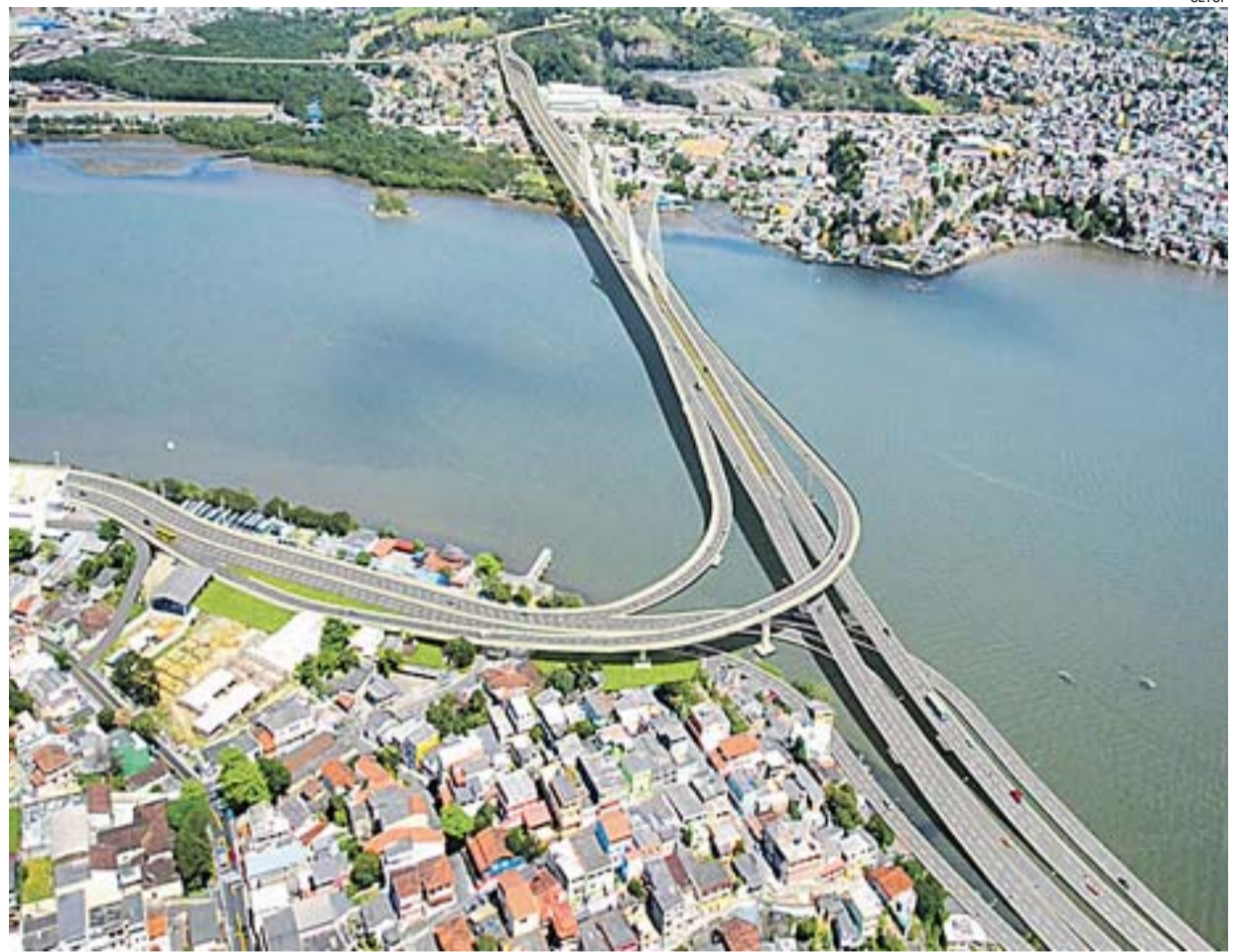
PERSPECTIVA DA QUARTA PONTE: obra que vai contar com corredor exclusivo para ônibus do sistema BRT
