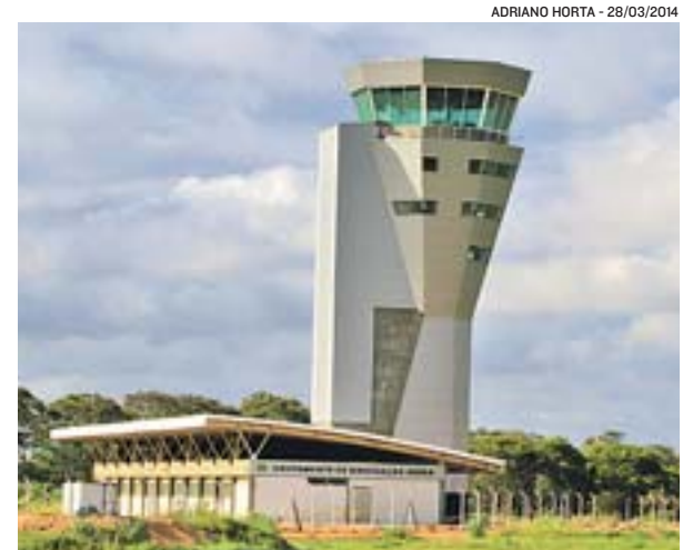
NOVA TORRE de Controle do aeroporto de Vitória: o equipamento ILS vai ajudar na redução de desvios de rotas para pouso em Vitória, por causa do mau tempo, segundo especialista
