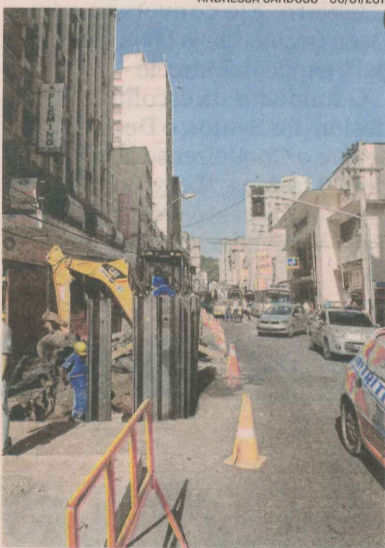
OBRAS no centro de Vitória
