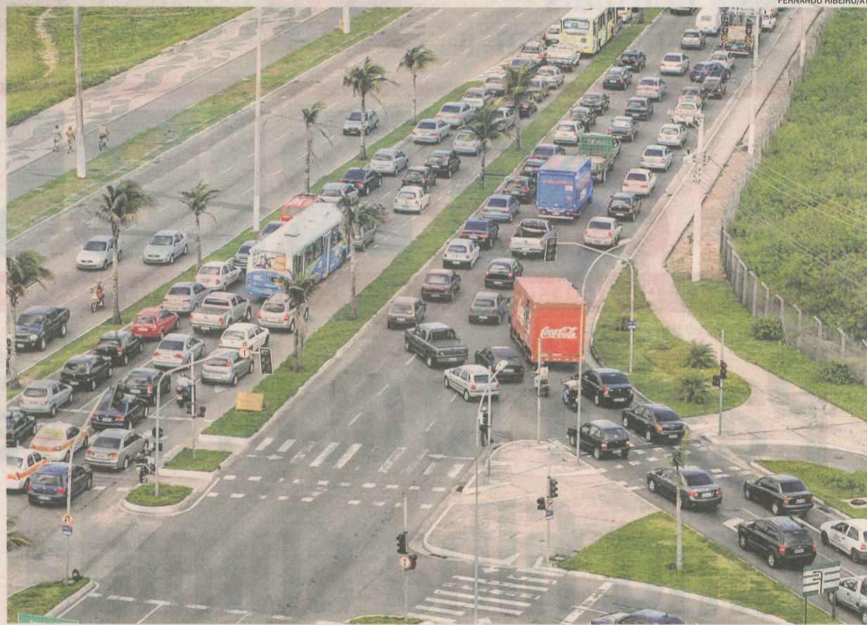
TRÂNSITO ENGARRAFADO na Dante Michelini, devido a obras de recapeamento que vão durar 15 dias
