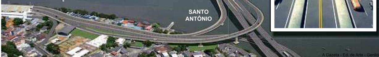
**A ponte terá quatro vias em cada sentido:** duas para veículos, uma no meio só para ônibus – corredor exclusivo – e uma ciclovia na extremidade, além de passagem para pedestres
