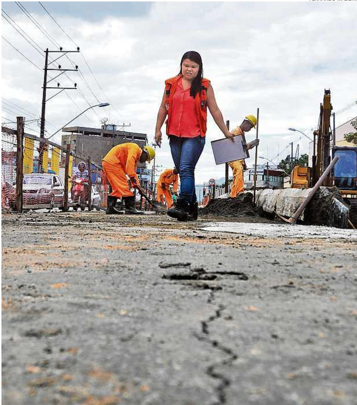
**O asfalto cedeu depois que o problema numa rede de esgoto que passa sob a via arrastou terra**
