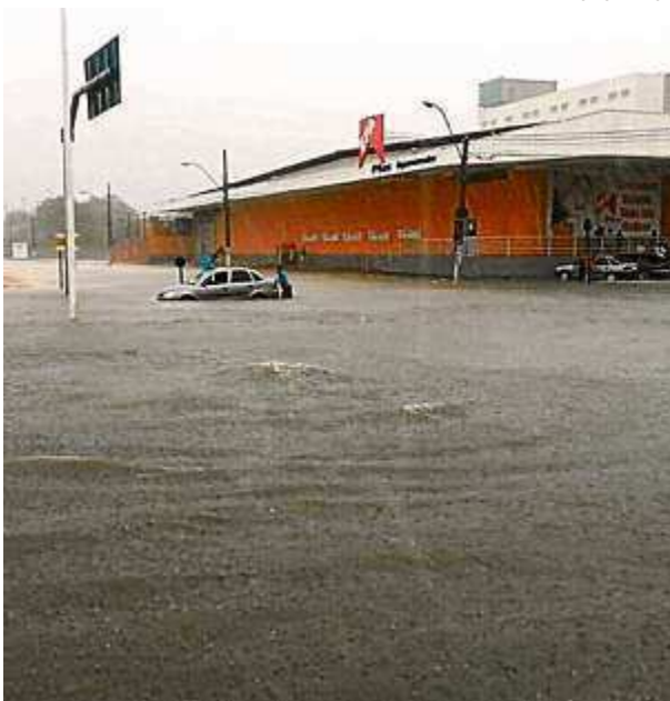
Avenida Eudes Scherrer, em Laranjeiras: alagamento
