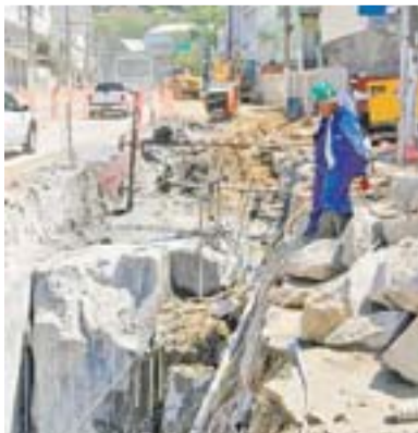
TRABALHO para retirada de pedras
