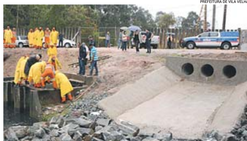
FUNCIÓNÁRIOS da prefeitura instalam bombas no canal de Guaranhuns
