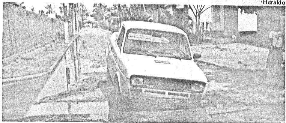
Sem tampa, o bueiro tem provocado acidentes com muita frequência
