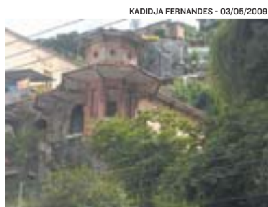
PRÉDIO antes do desabamento
