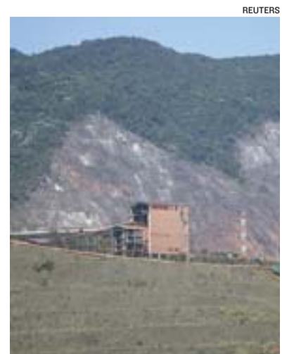
MINA de minério de ferro em Minas
