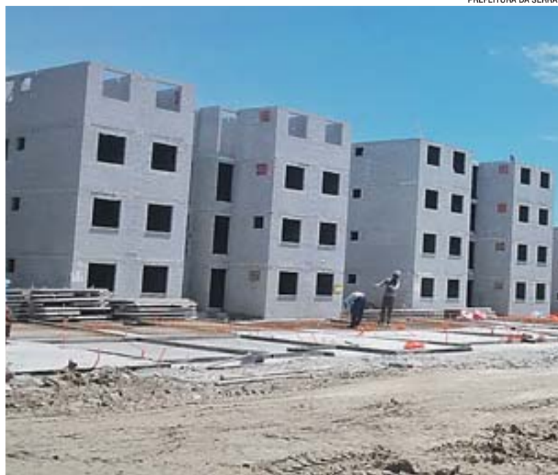
UNIDADES HABITACIONAIS estão sendo construídas em Ourimar
