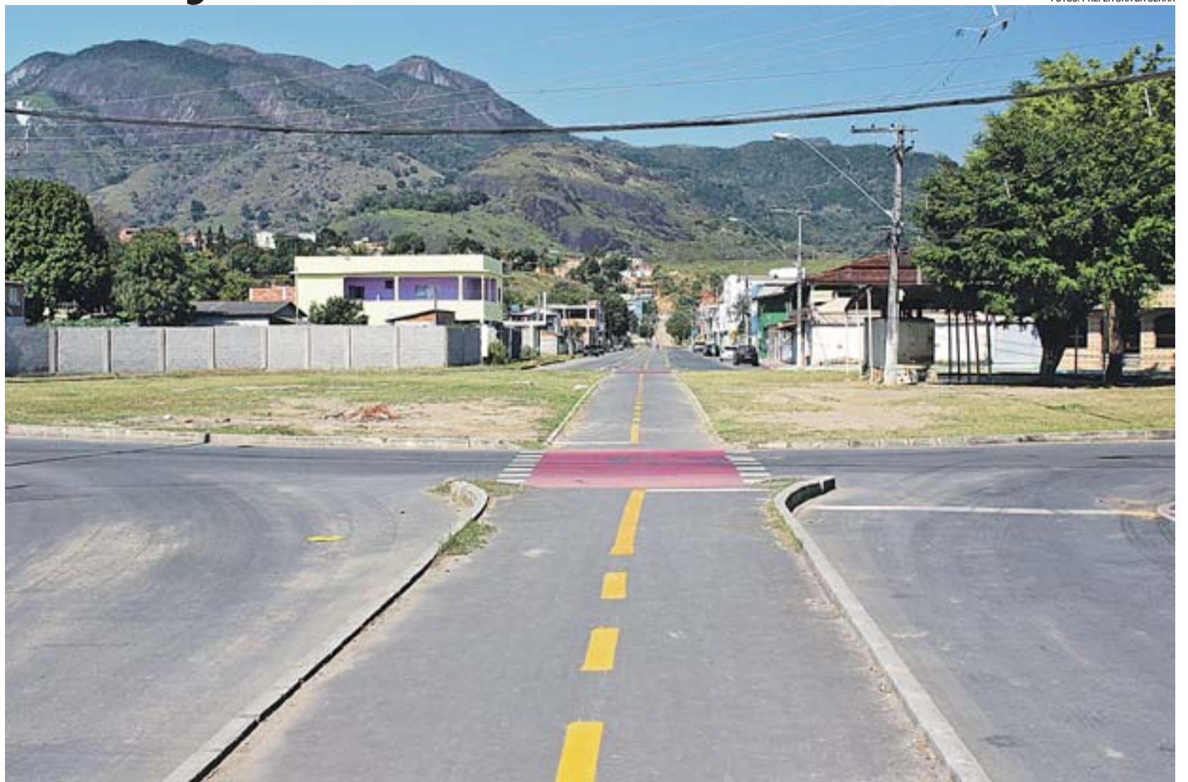
AVENIDA ARGENTINA é uma das vias que recebeu obras de drenagem, pavimentação e recapeamento neste ano
