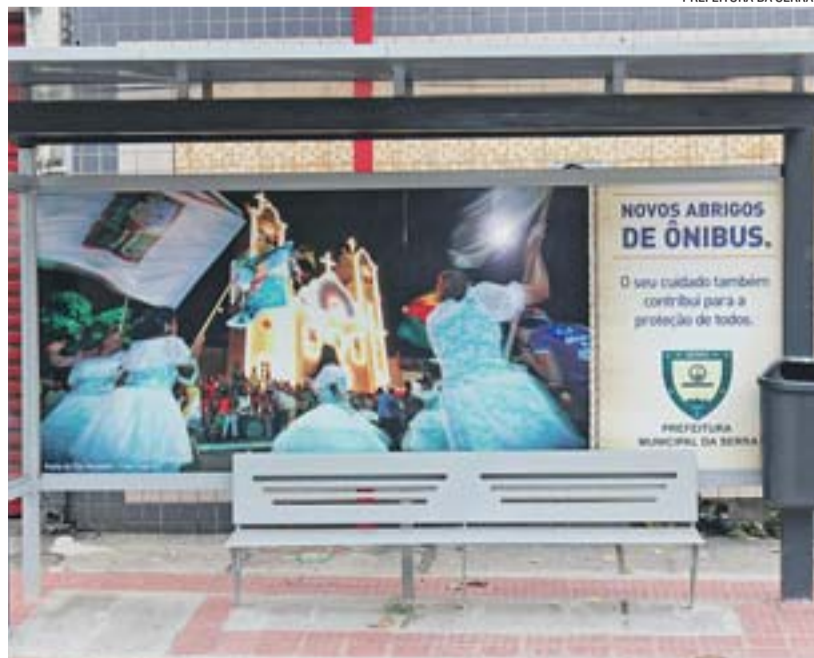
NOVOS ABRIGOS têm estrutura metálica e são vedados em vidro
