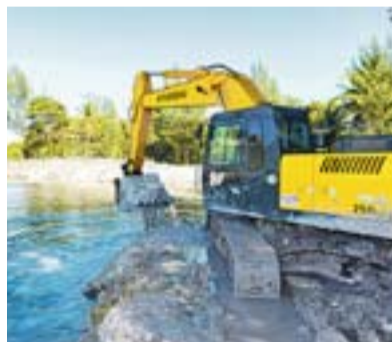
18 MIL METROS de rede drenadas
