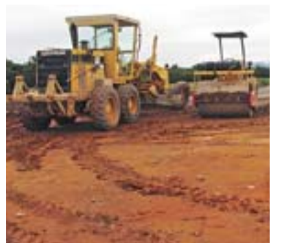
OBRAS DE PAVIMENTAÇÃO do contorno de Jardim Carapina
