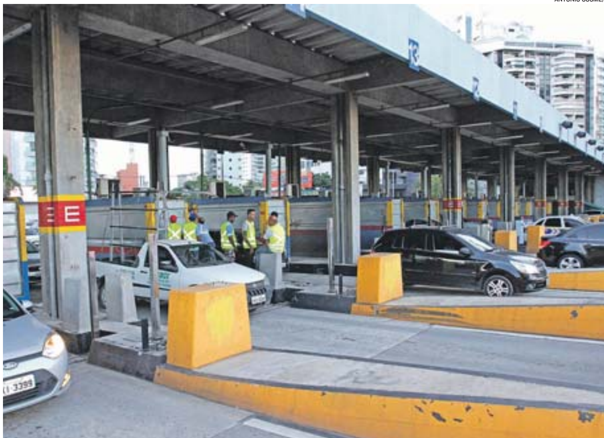
CABINES DE PEDÁGIO DA TERCEIRA PONTE: funcionários estão sendo recontratados para volta da cobrança
