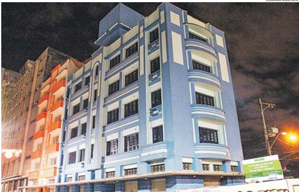
EDIFÍCIOS POUSO REAL E TABAJARA, em Vitória, foram reformados dentro do projeto Morar no Centro
