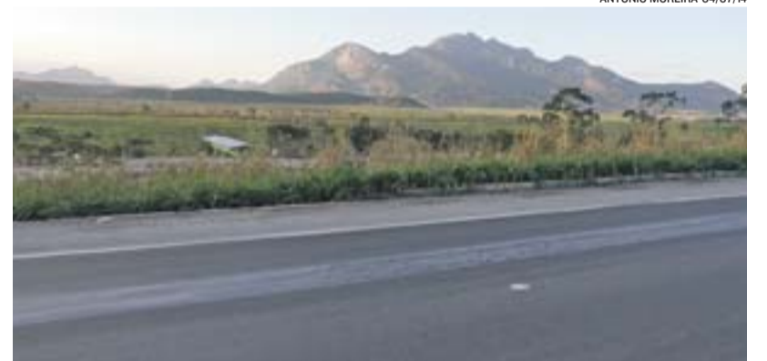
VISTA DA ÁREA onde está sendo construído o Contorno do Mestre Álvaro
