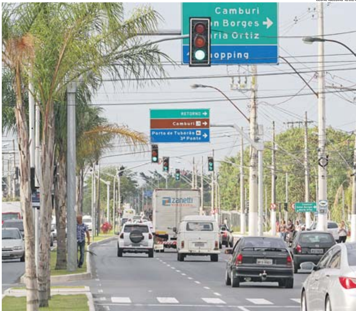
A AMPLIAÇÃO da avenida Fernando Ferrari, em Vitória, garantiu o aumento de capacidade de fluxo da via em 50%
