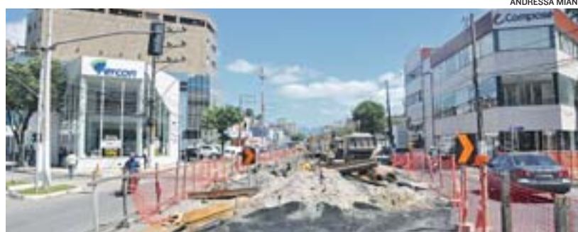
OBRA EM GALERIA faz parte da ampliação da avenida Leitão da Silva
