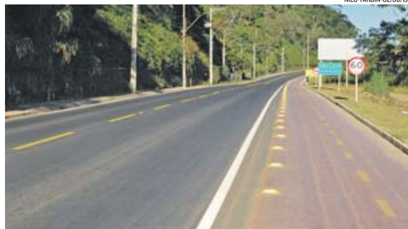
RODOVIA ES-261, que liga Fundão a Santa Teresa: monitoramento
