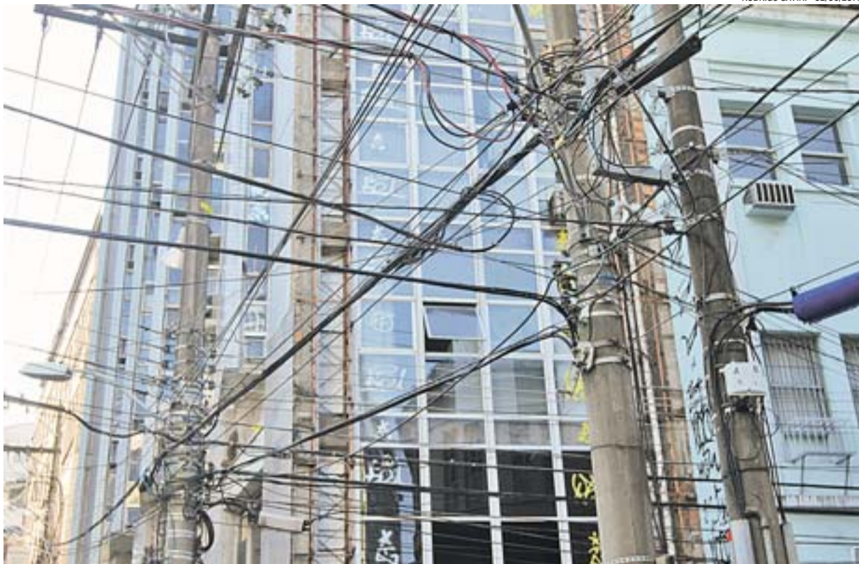
FIOS EM AVENIDA DO CENTRO: reuniões de consulta pública sobre as novas normas da cidade serão realizadas
